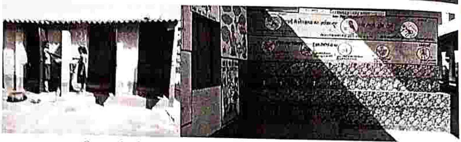
विद्यालय में शौचालय में जल आपूर्ति एवं पेयजल हेतु पाइप स्टेशन का निर्माण
